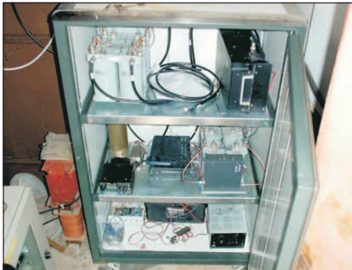
Fig. 1 - Batteria di 6 cavità Forem in uso in un ripetitore amatoriale in UHF
